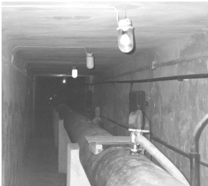
Рис.2а. Общий вид кюветы ВКМ-100 после реконструкции.
