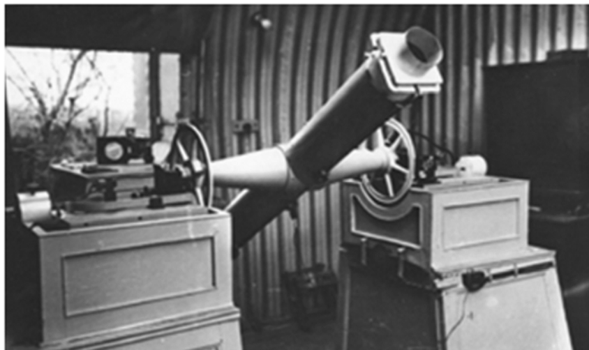
Рис. 3. Пассажный инструмент Фрейберга-Кондратьева ( D = 108 \text{ mm} , F = 1300 \text{ mm} ).
