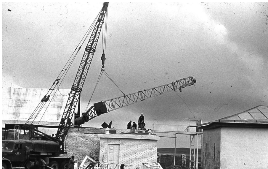
Монтаж Большого коронографа
